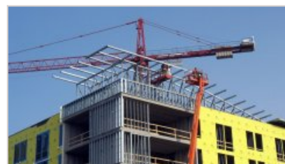
Abitazioni e immobili
