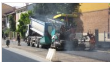
Circolazione stradale e cantieri
